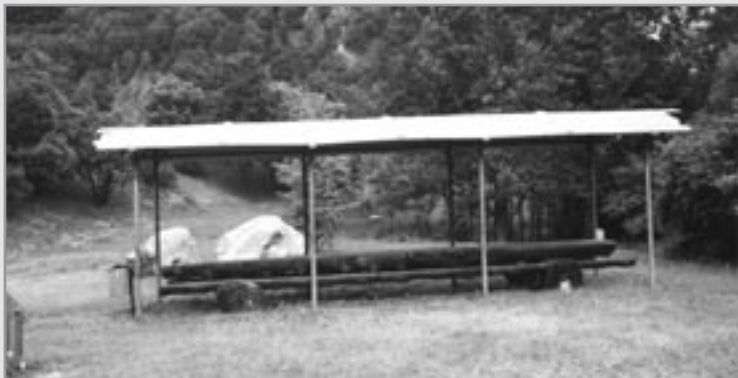
Realizzazione della copertura con assito di larice del gazebo nell'area verde del centro polifunzionale
