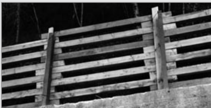
Realizzazione della palizzata paramassi lungo la strada comunale di Migondo
